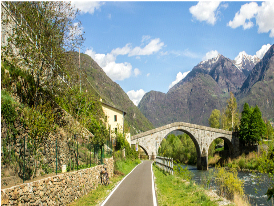
Ponte di Ganda
