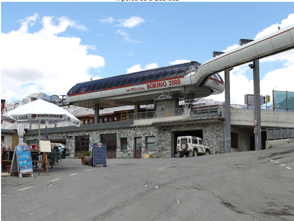
Gli impianti di risalita a Bormio 2000
