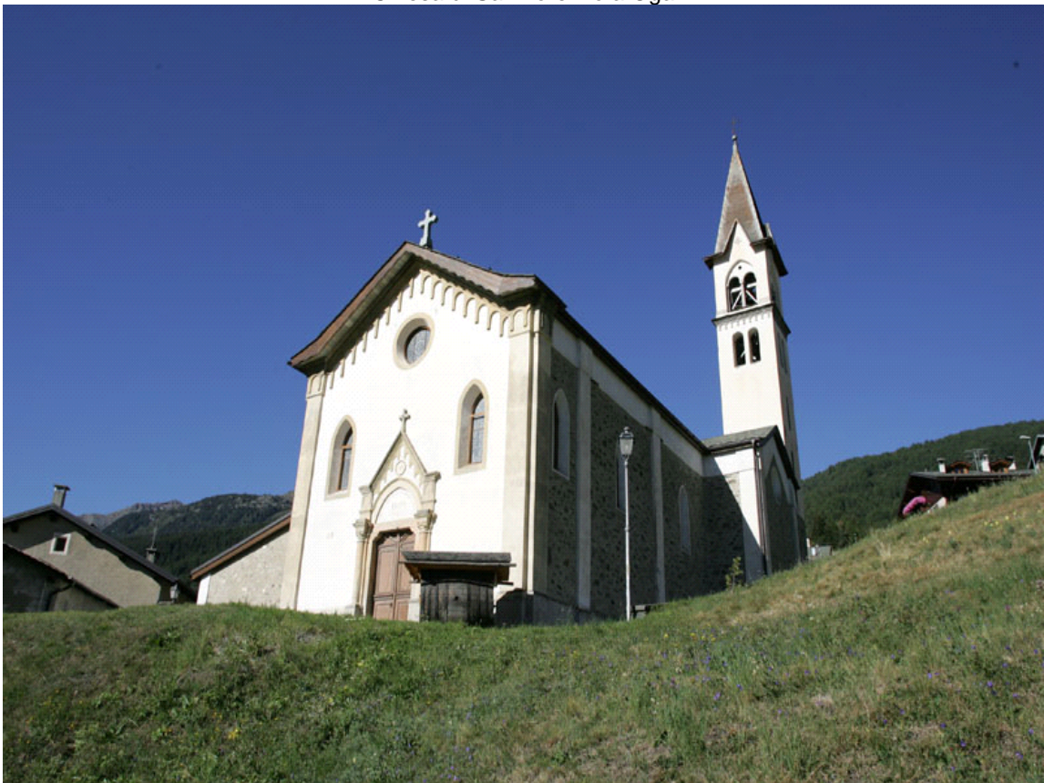
Primo piano della chiesa di San Lorenzo a Oga
