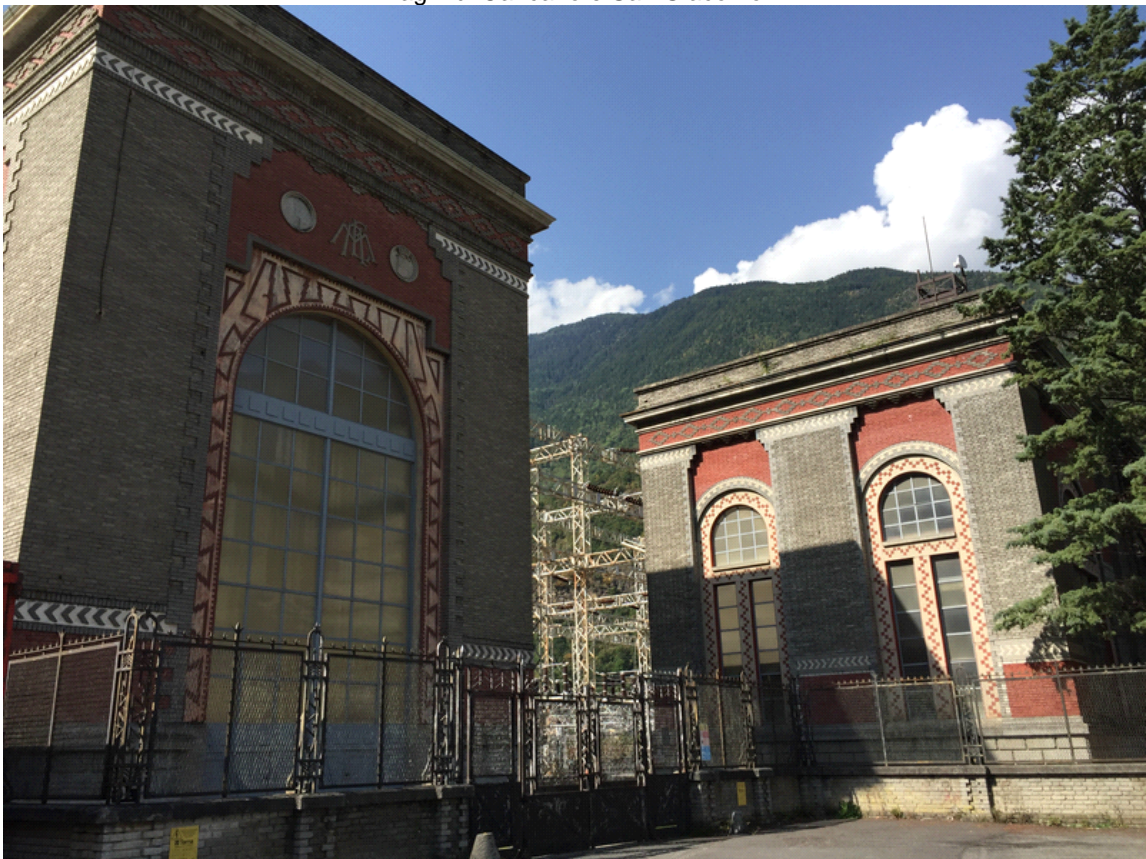
Centrale di Grosotto
